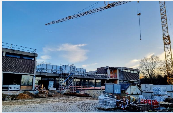
Die Bürgerhaus-Baustelle: Die Insolvenz des Architekturbüros führt zu weiteren Verzögerungen.
